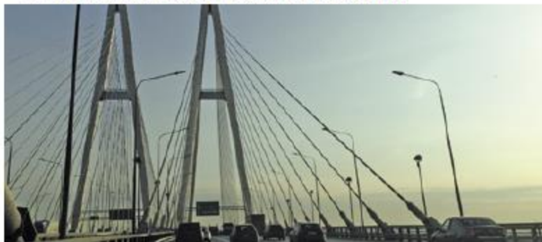
г. Санкт-Петербург, Обуховский мост
