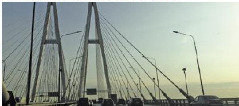
г. Санкт-Петербург, Обуховский мост
